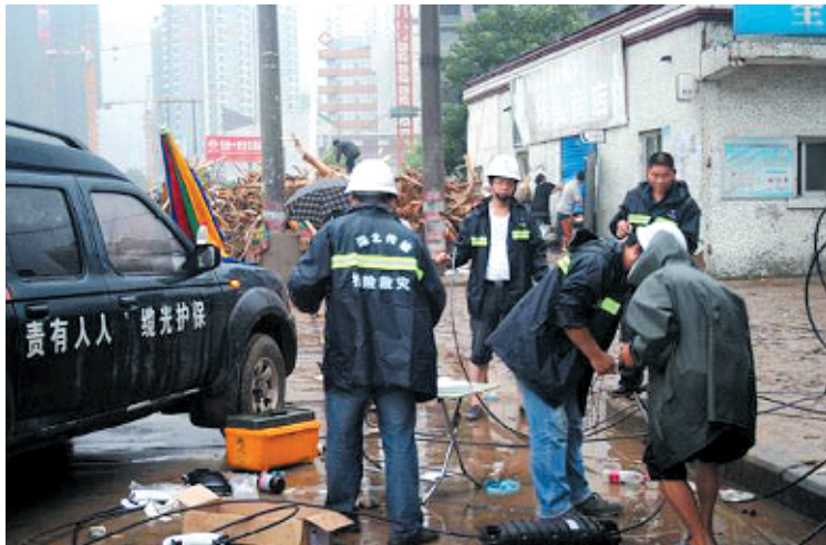
冒雨抢修光缆保通信畅通
