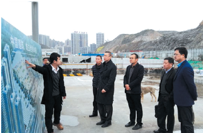
深入项目施工现场调研
