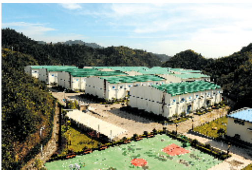
十堰粮油集团中心储备库
