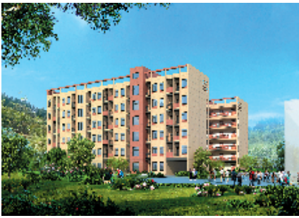
郧西县第一中学学生宿舍楼;荣获十堰市建筑结构优质工程、安全文明施工现场
