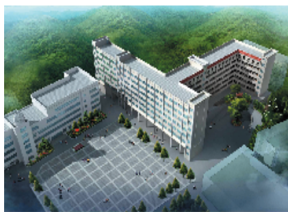
十堰市一中南区学生宿舍楼及还建教室
