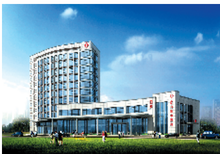
竹山县中医医院;荣获湖北省建筑结构优质工程、安全文明施工现场
