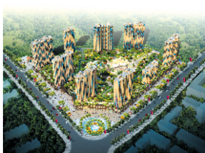
风神大道安置区(风神水齐·乐业城):1-5号楼荣获湖北省建筑结构优质工程、安全文明施工现场
