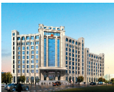
郧县人民检察院办案和专业技术用房;荣获湖北省建设优质工程-楚天杯
