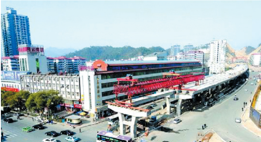
中岳路高架桥
