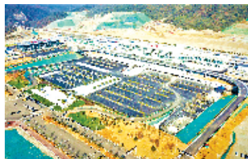
汉十高铁十堰东站配套设施工程全面完工
