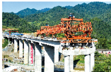
十巫高速桥梁施工
