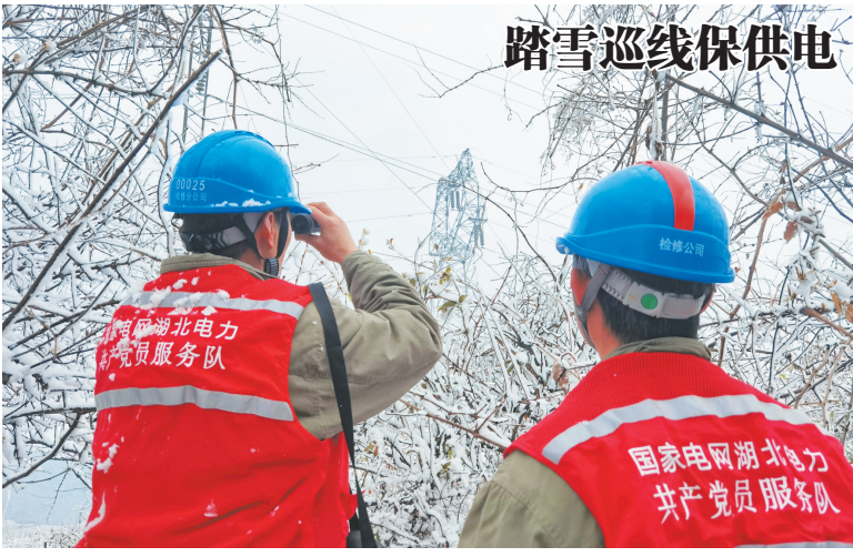
1月25日,国网十堰供电公司输电运检分公司特巡人员深入茅箭区大川镇,对高压电力线路进行巡检,排查化解安全隐患,保障电力供应平稳可靠。 记者全正 通讯员郭沛丰 摄
