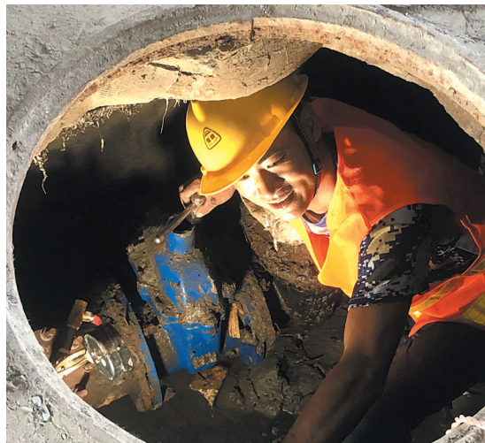
抢修供水管道
