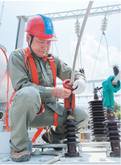
8月15日，在鄖阳区110千伏长岭变电站内，肖君君在烈日下测试避雷器的运行状态。
