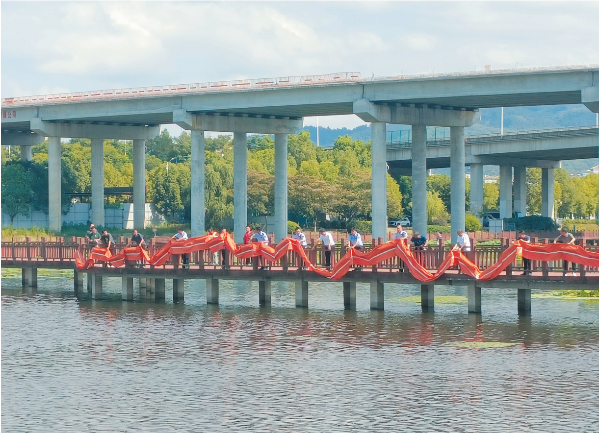
应急人员在铺设拦油索
