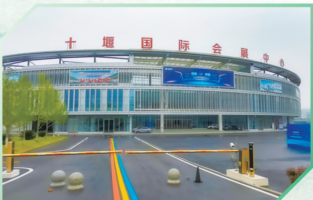
十堰国际会展中心室外展区场地平整等工作已完成
