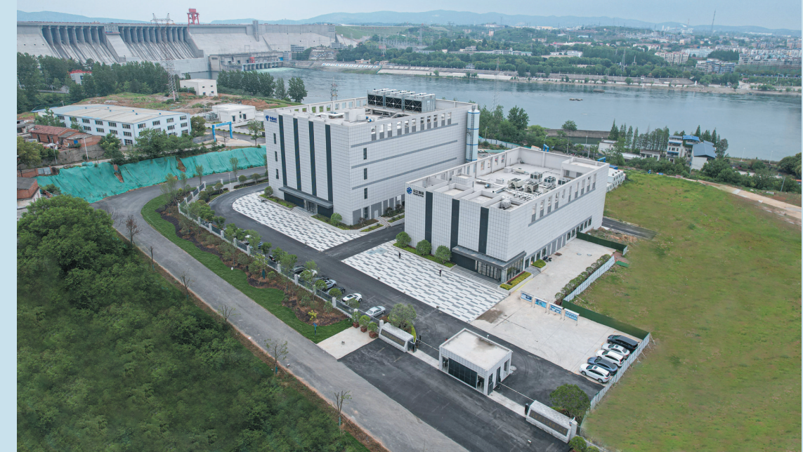
武当云谷冷水大数据中心
