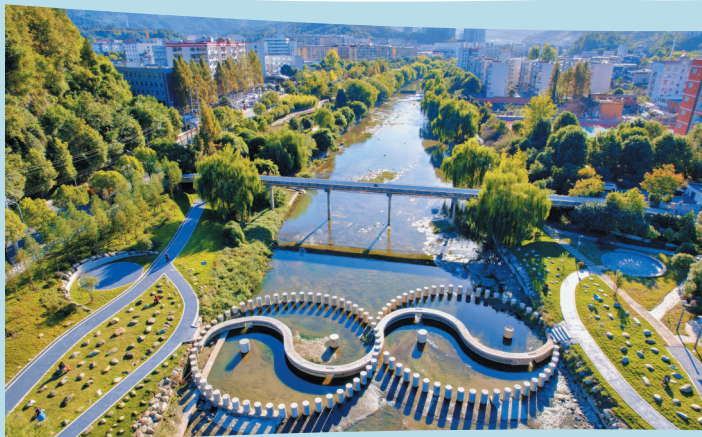
泗河流域马家河下游水生态修复工程 记者全正 摄
