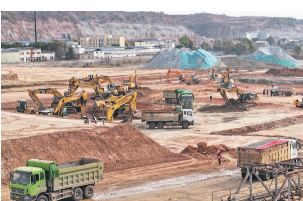
陈家港“铁水空”联运基地项目加速推进。
