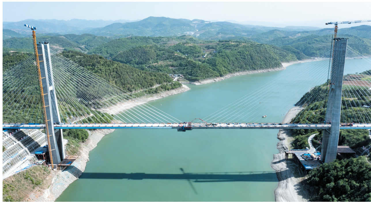
西十高铁汉江特大桥成功合龙。记者刘昆 摄
