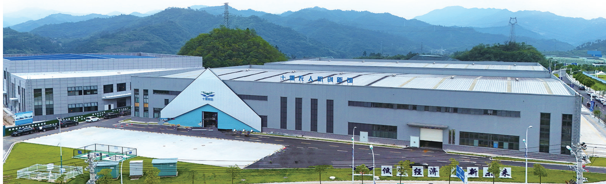
张湾区低空经济产业园。
