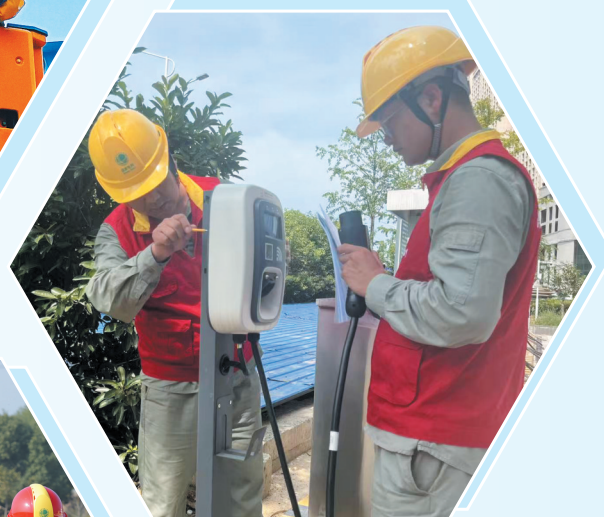
检查充电桩设备状态及辅助设施。
