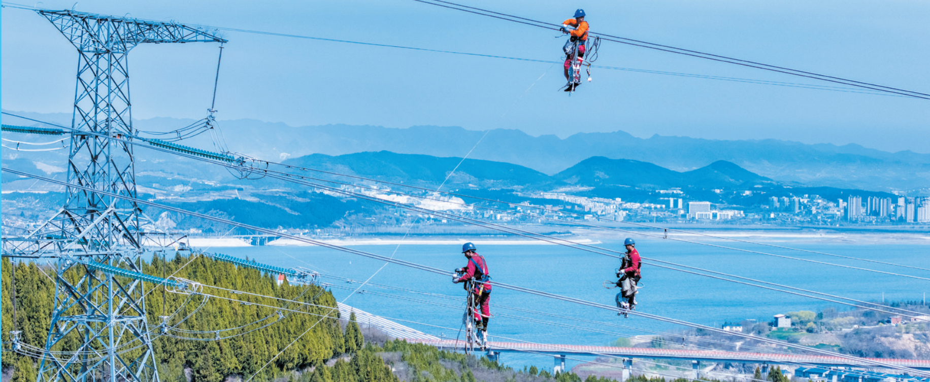
电力工人开展输电线路施工作业。
