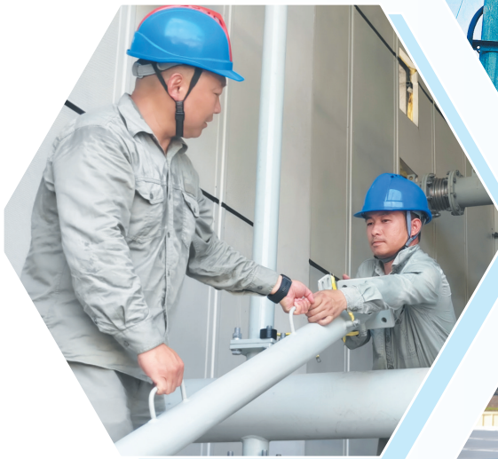
工作人员正在安装新建110千伏武汉万家湖变电站主变附件。
