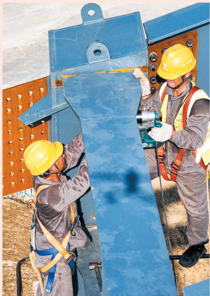
东风商用车原41厂大冲车间改造利用项目(一期)工程、商用车论坛永久会址建设现场,施工工人头顶烈日焊接钢结构。记者张建波 摄
