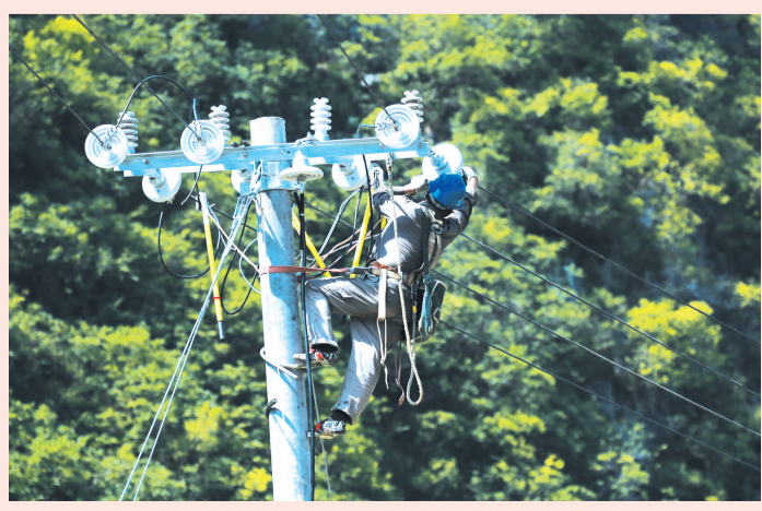
郧西县上津镇,电力工人正攀爬电杆检修线路。记者刘昆 摄
