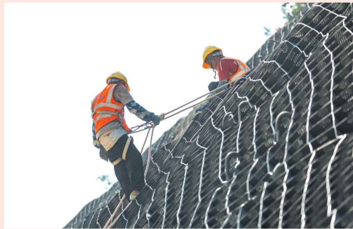
十堰双高路施工现场,工人们头顶烈日铺设边坡防护网。记者刘昆 摄
