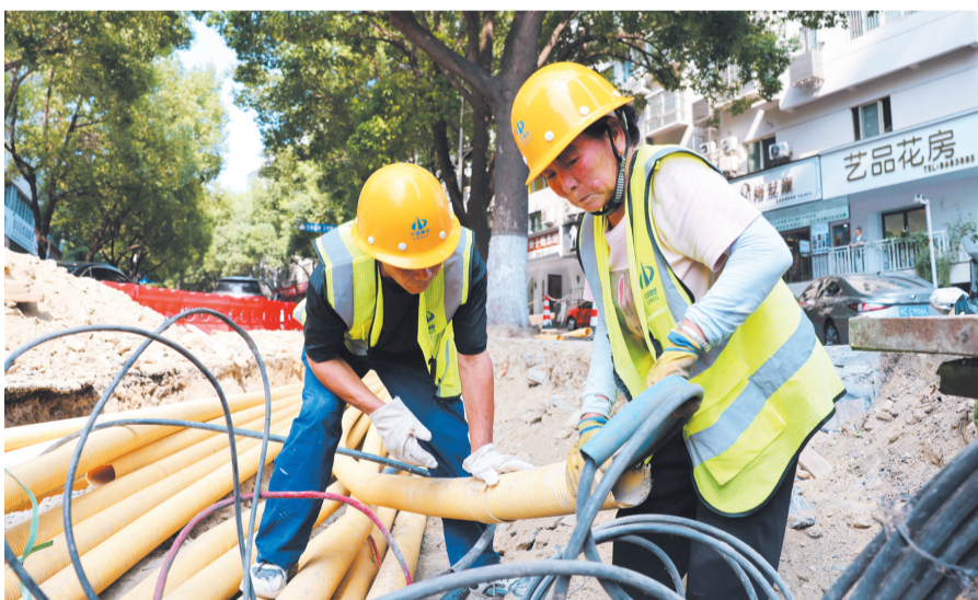
江苏路人行道改扩建工程施工现场,工人们正在清理管线。记者张建波 摄
