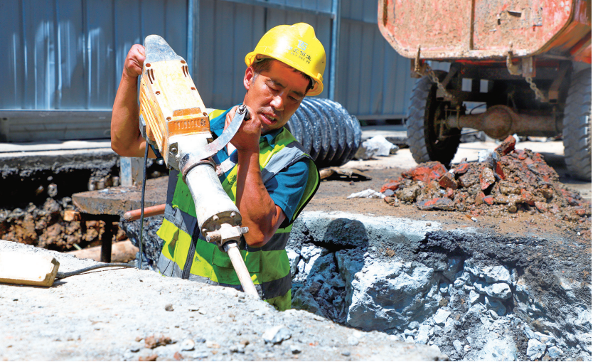
烈日下,范吉兵拿着电镐挖管沟。
