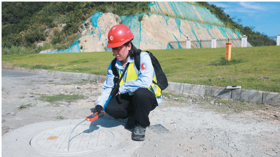
罗旋手持燃气检测仪检测管井。
