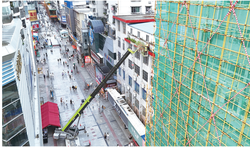
五堰香港街沿街建筑的外立面修缮、店铺招牌的更新工作正加紧推进。
