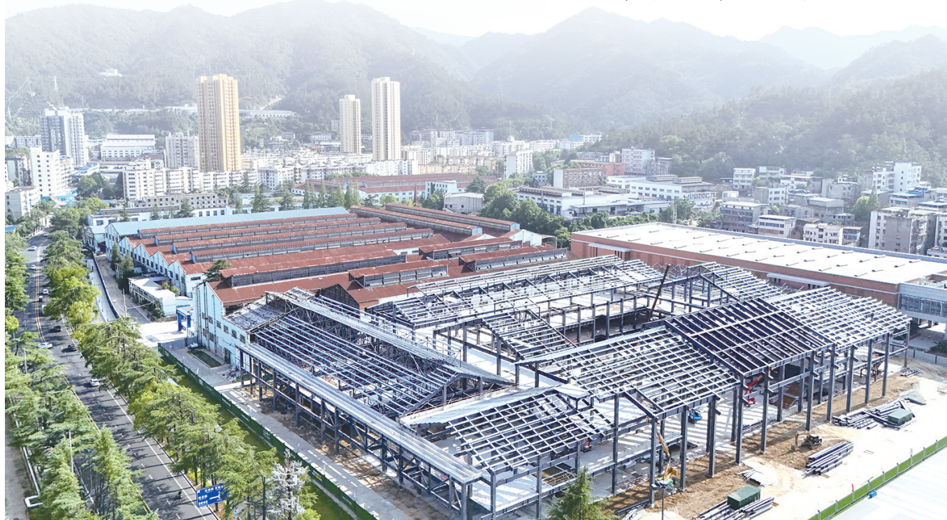
原东风汽车公司41厂大冲车间改造利用项目中,汽车文化街区的会议中心主体已完工。该项目旨在打造工业遗产更新的标杆,建成后将助力我市保护好、传承好“汽车城”品牌,重塑车城新形象。
