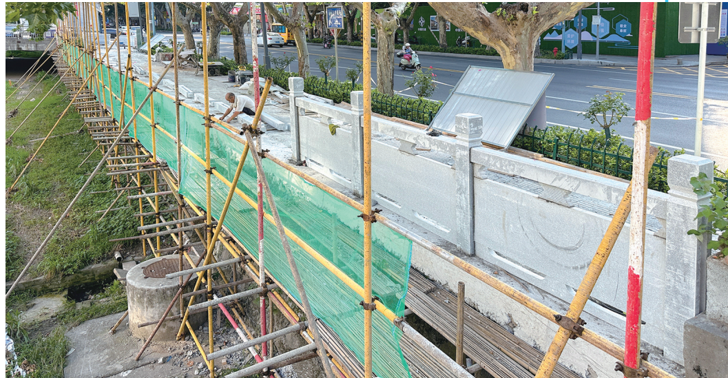
张湾区车城西路正全面修复破损路面,更换护栏、道牙及人行道铺装,实施绿化升级,以实现道路功能性与景观性的双提升。
