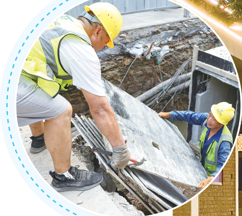
在五堰香港街南街片区,施工人员正加紧对地下管网实施修复及雨污分流改造。
