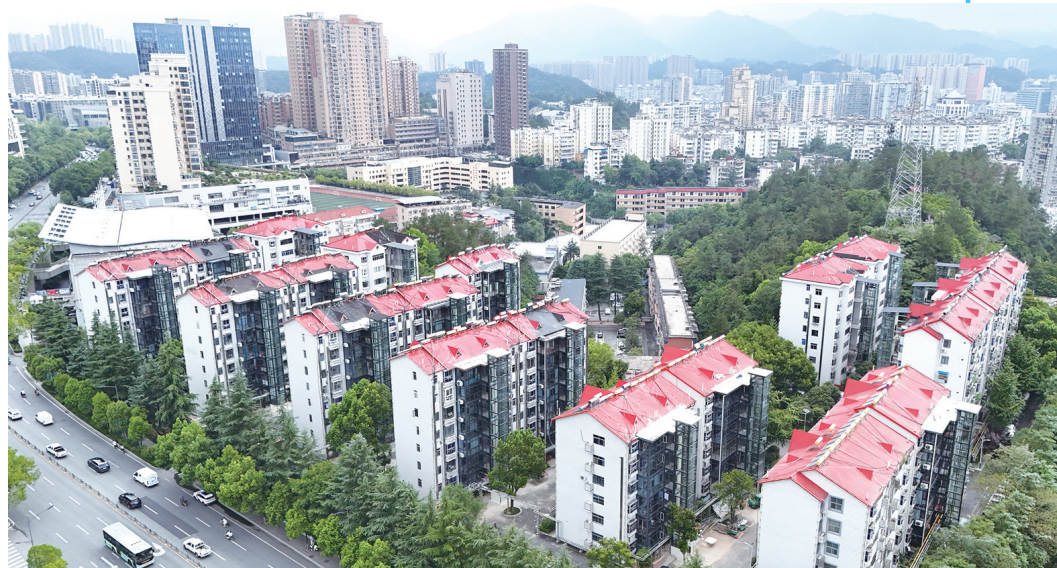
茅箭区北京路郢中家园小区的20个单元已全部加装电梯,原本的老楼变身“电梯房”,居民的生活质量因此得到显著提升。
