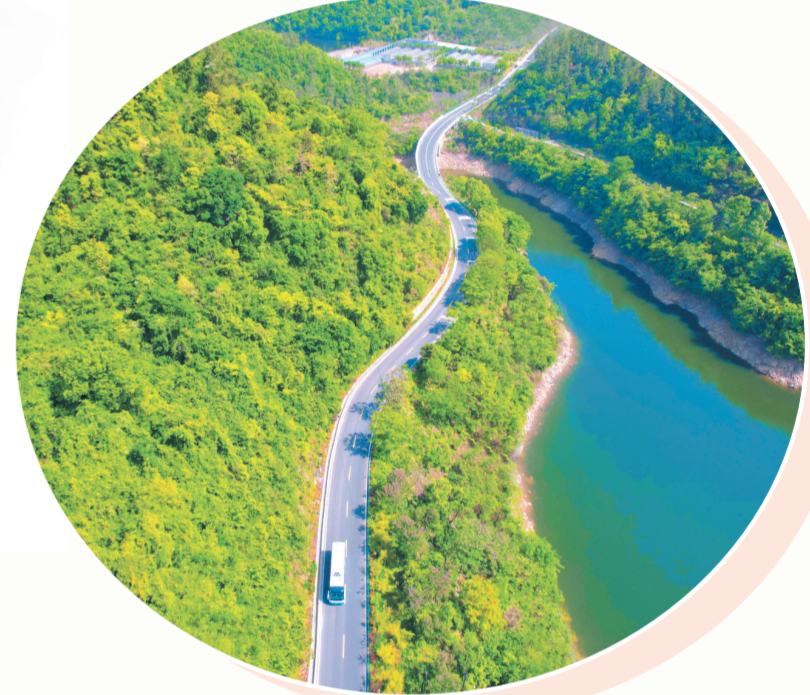
畅通农村路网。记者金正 摄
