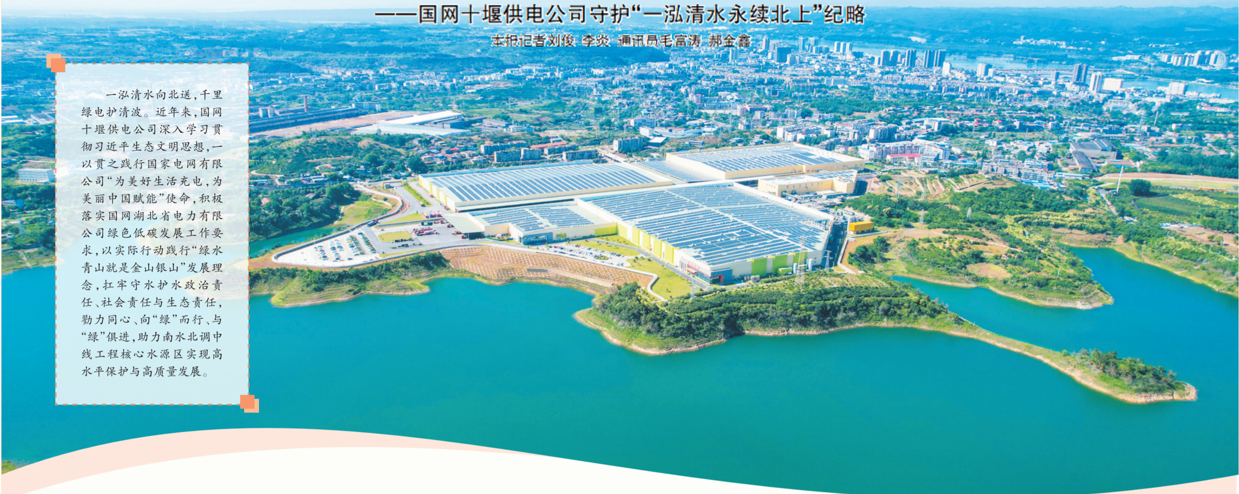
国网丹江口市供电公司利用企业闲置屋顶建设分布式光伏发电系统，为企业提供安全可靠的清洁能源。
