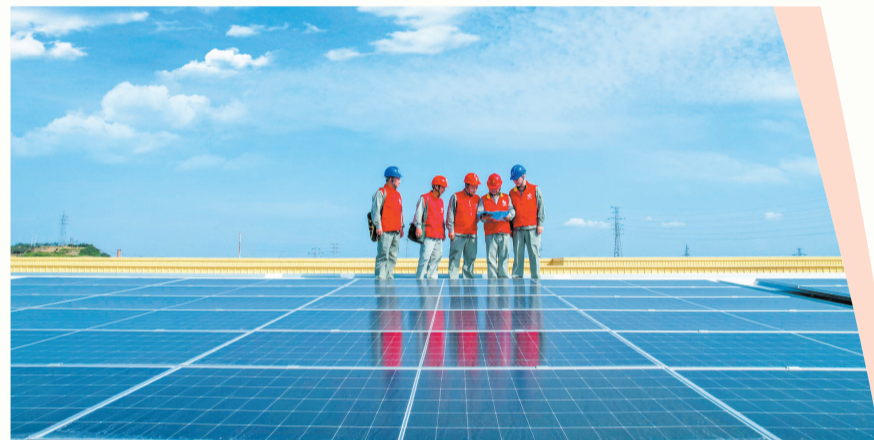
国网巨能新兴产业发展分公司工作人员对光伏发电项目进行验收。
