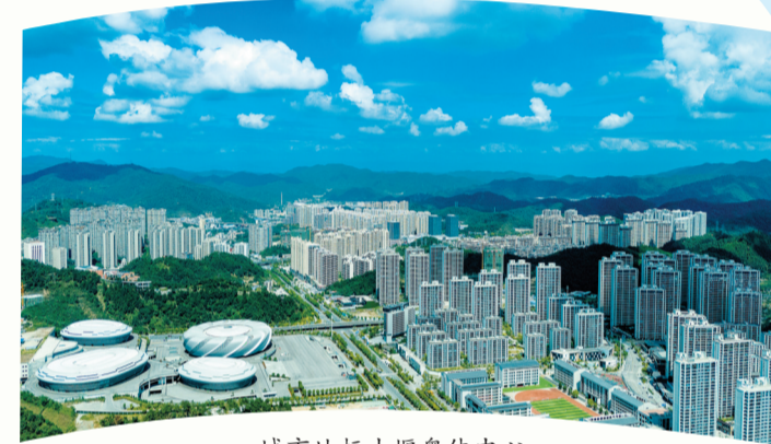
城市地标十堰奥体中心。
