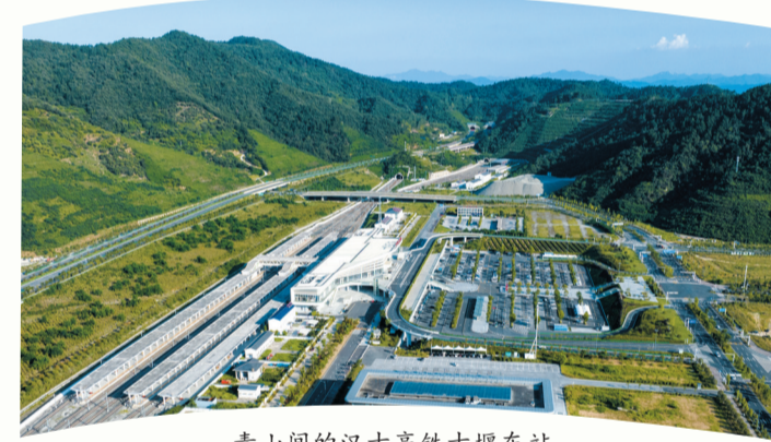
青山间的汉十高铁十堰东站。
