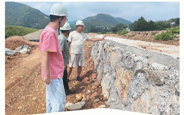
刘河镇纪委工作人员深入施工现场开展民生监督。
