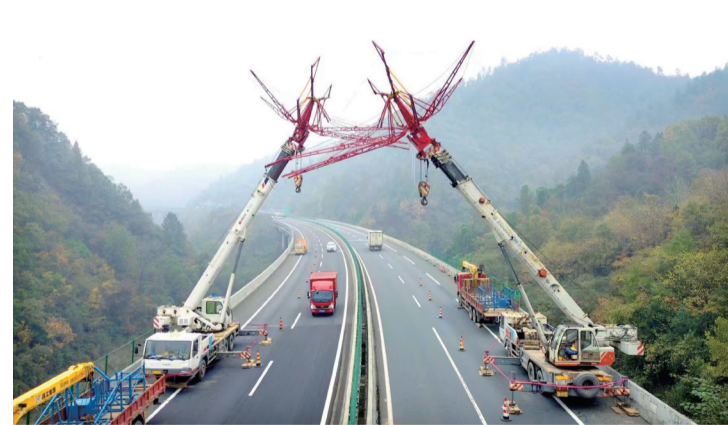
“移动式伞形跨超车”缩短了风险作业时间,助力提高效率、保障安全。
