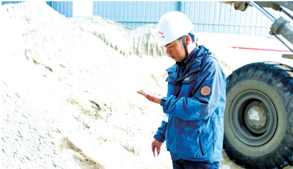
陈永胜对混凝土基础材料砂质进行严格检查。
