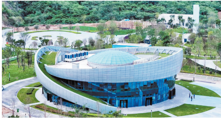
郧阳区域城关镇污水处理厂外观。(资料图片)
