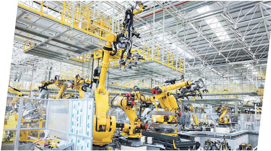
试生产中的东风商用车车身智能制造新工厂。记者张建波 摄
