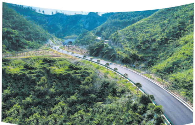
郧西县工业园至家竹公路改扩建工程。
