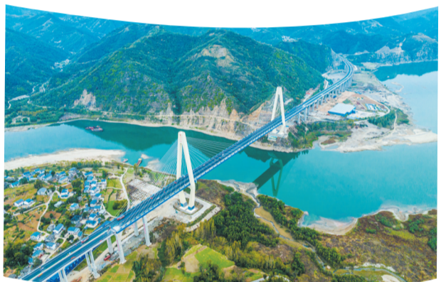
十巫北高速公路汉江特大桥。
