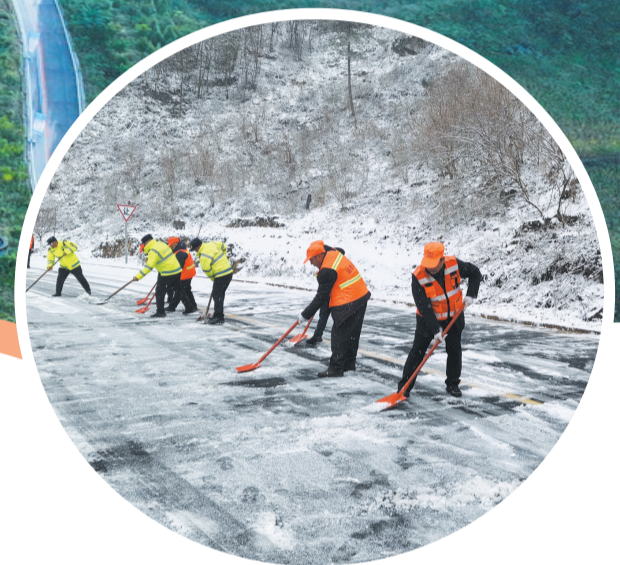
郧西县交通运输部门积极应对雨雪冰冻天气。
