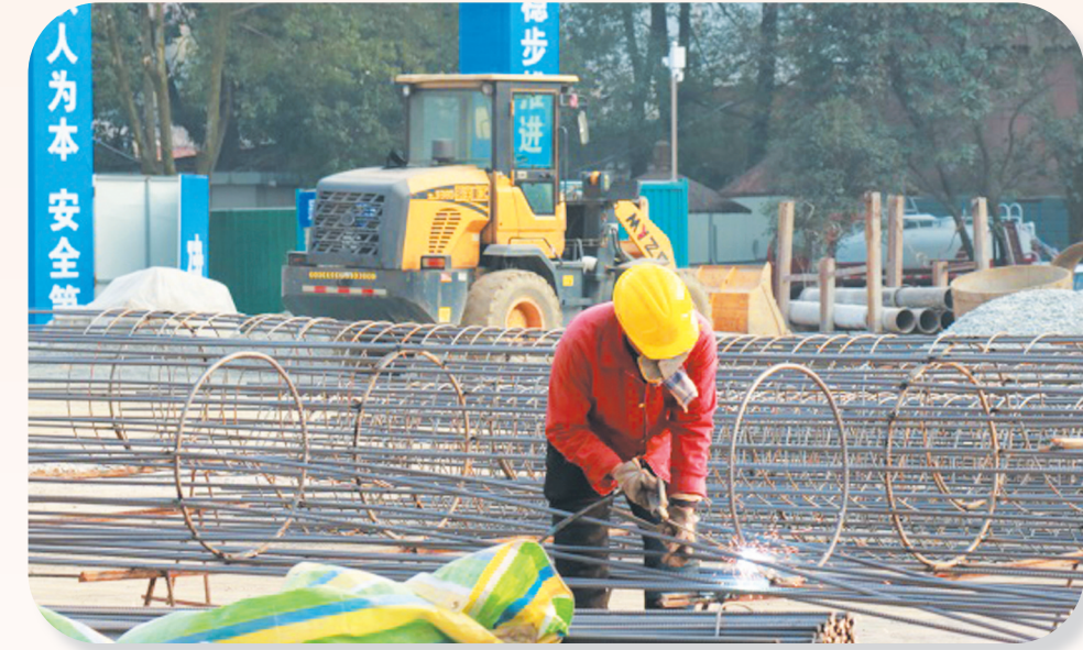
市特殊教育学校迁建项目(一期)工地上,工人正在忙碌施工。
