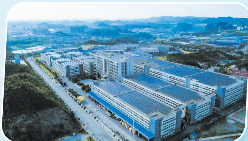
新能源汽车产业园建设多层厂房，践行绿色发展理念。
