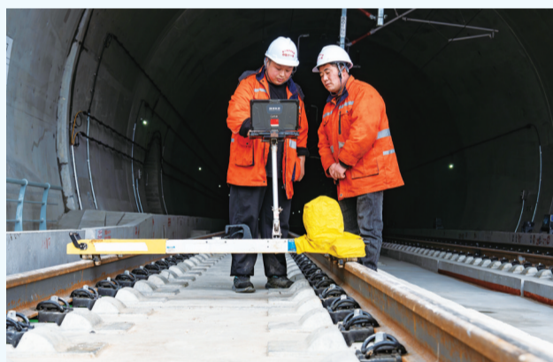
工程师用廓形仪对钢轨进行检测。记者金勤 摄
