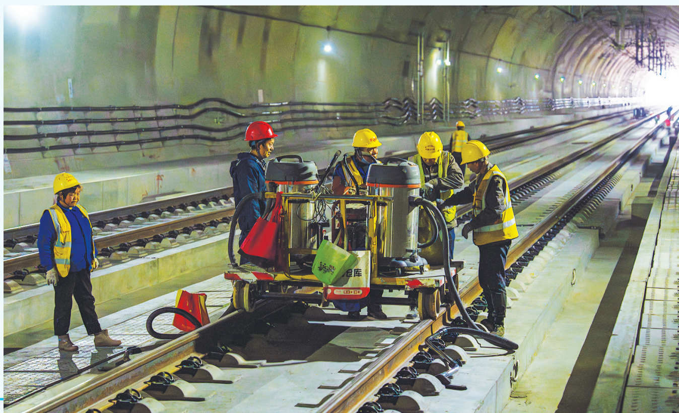
工人用吸尘器吸取细微粉尘。记者刘昆 摄
