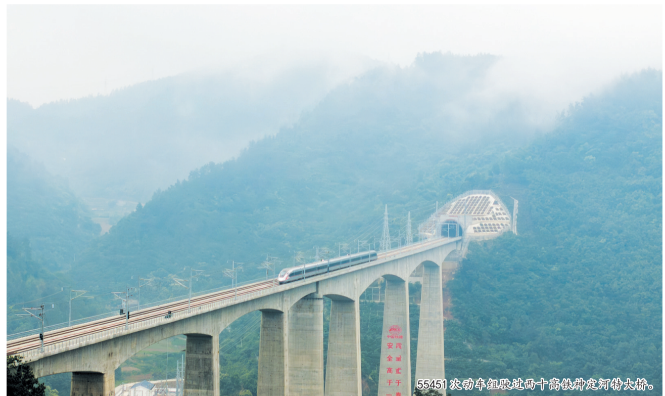
55451次动车组驶过西十高铁确定河特大桥。
