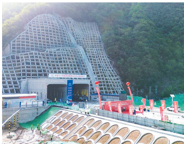
2025年4月23日,全长22.9公里的西十高铁秦岭马白山隧道顺利贯通,这是目前国内已贯通的最长高铁隧道。西安日报记者梁璠 摄
