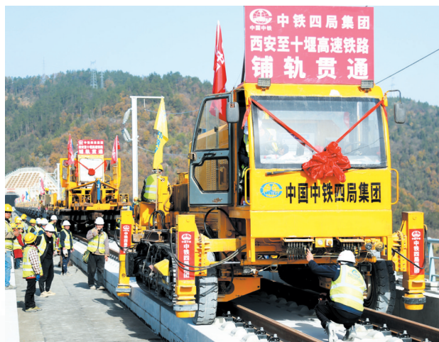
2025年11月27日,西十高铁全线铺轨贯通。记者刘昆 摄
