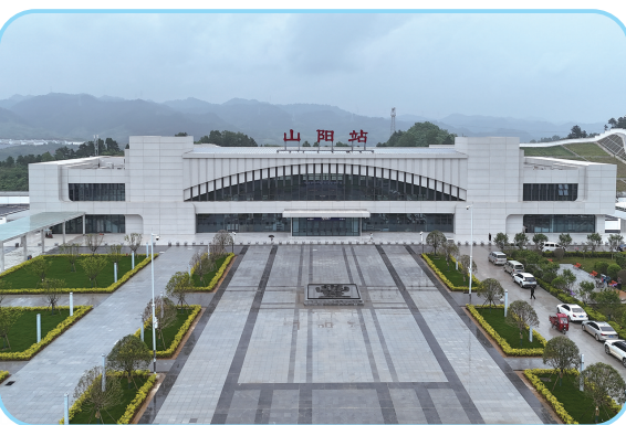
高铁山阳站。通讯员闫竹春 摄
