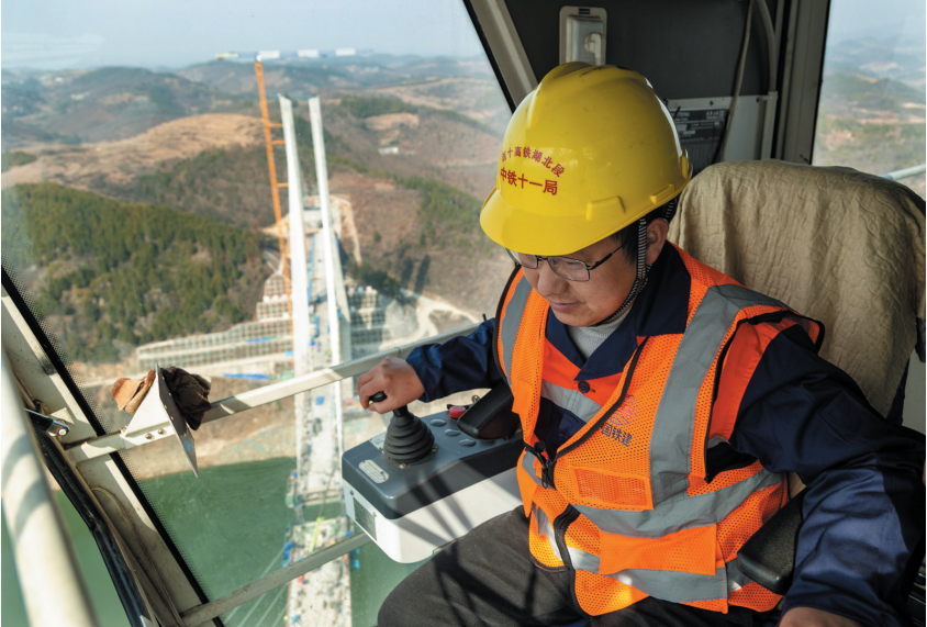
潘恒勇驾驶塔吊在西十高铁汉江特大桥上工作。(资料图片) 记者刘昆 摄
