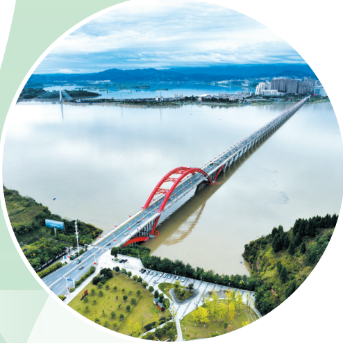
郧阳汉江大桥。
