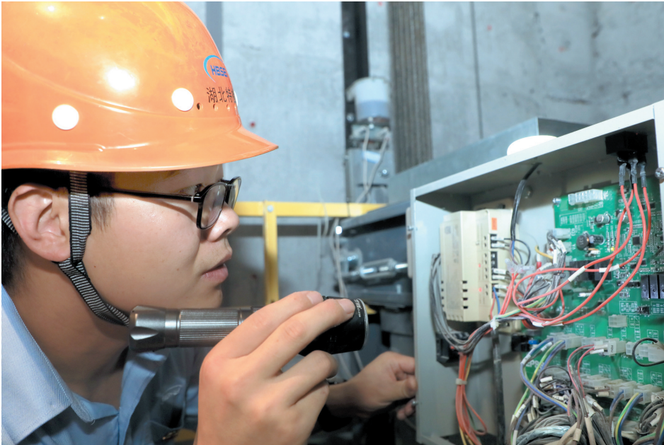
刘敏在井道检查电梯轿顶控制线路。
