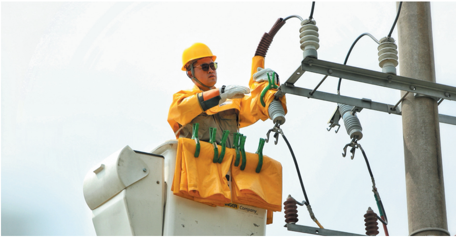
柯有良进行高温带电作业。
