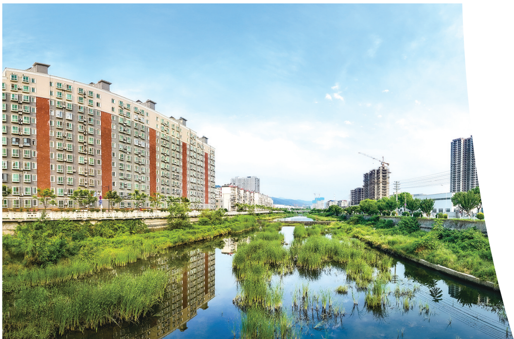
推进小流域综合治理,实施河道疏浚、水生生态修复。
