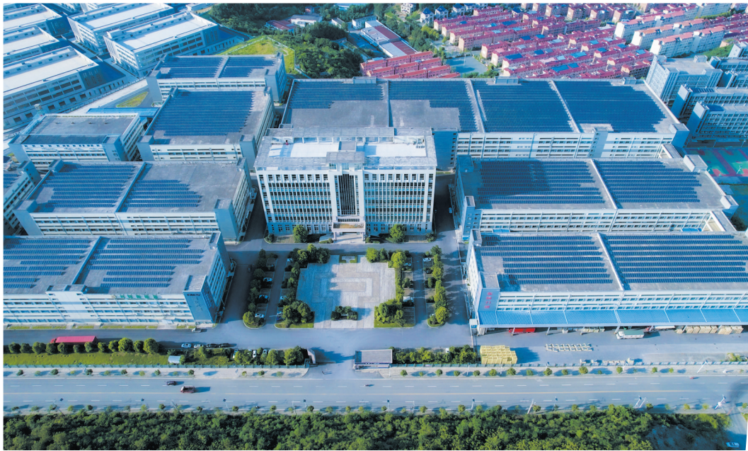
建设光伏屋顶,创建绿色园区。
