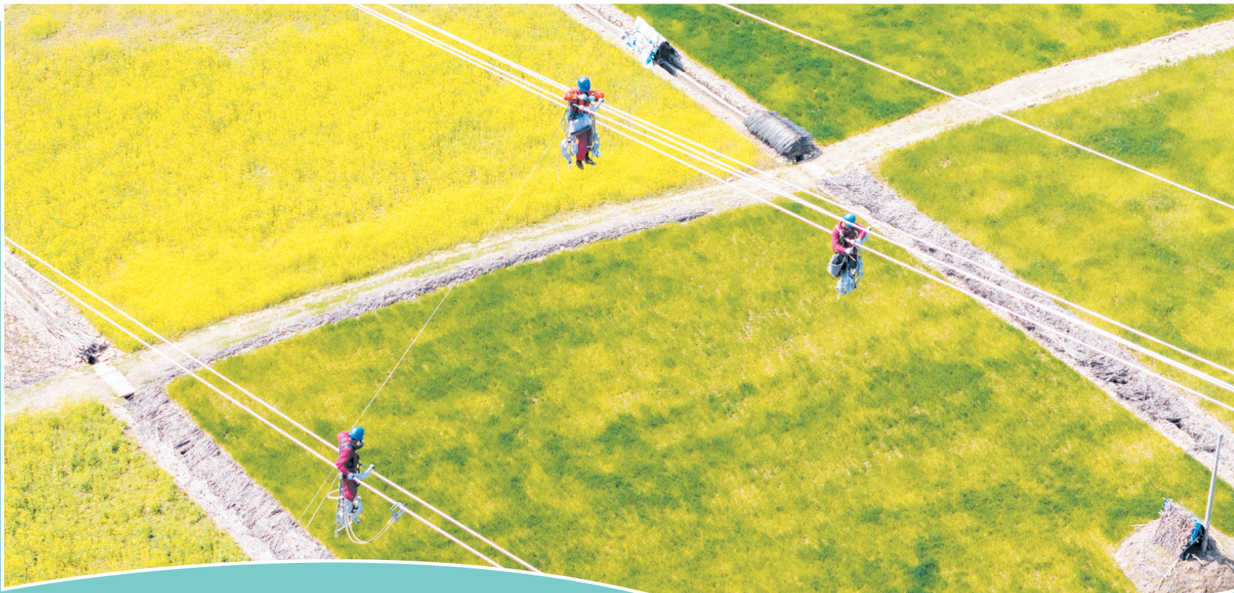
施工人员为西十高铁湖北段箭流铺、东河牵引站架设220千伏输电线路。通讯员王勇 摄
