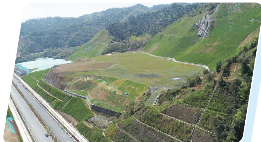
系统治理后的茅箭区朝北沟片区。
