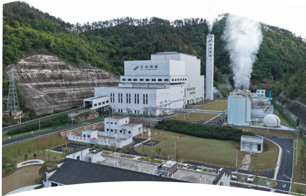
十堰市城区生活垃圾焚烧发电厂。
