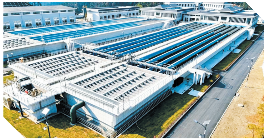
市城东水厂生产线并网运行。
