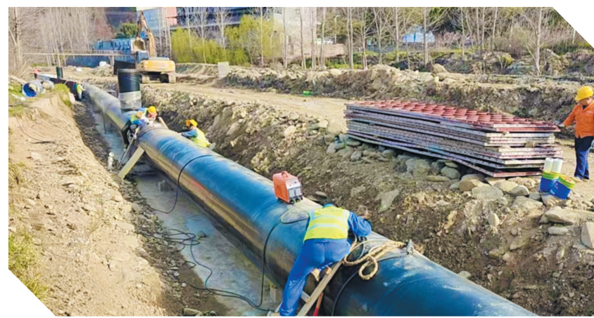
丹江口库区鄂河流域老化缺陷污水主管网改造工程有序建设。
