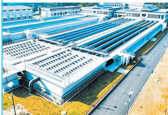
十堰城东水厂生产线并网运行。
