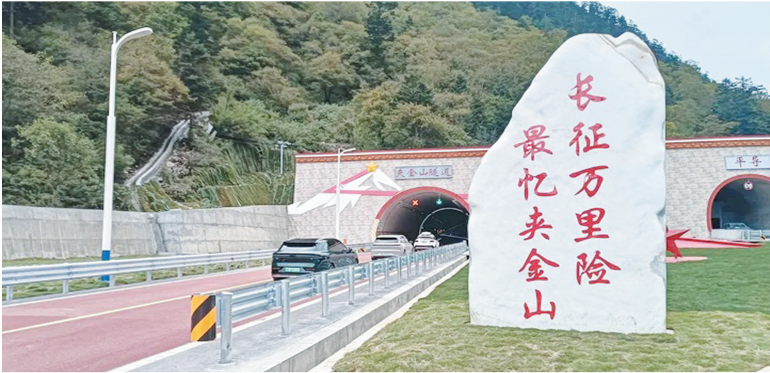
国道351线夹金山隧道宝兴端入口。雅安日报记者高菲菲 摄
