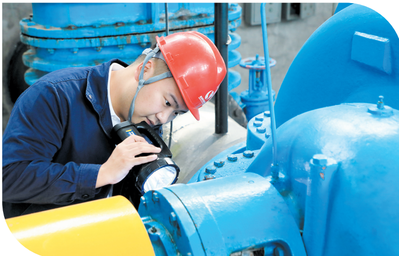
何彬琪在送水泵房巡查。
